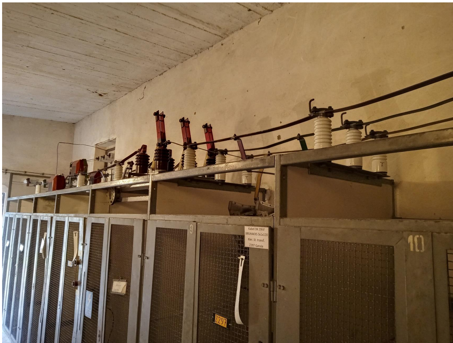
Rys. 6.6 Zdjęcie istniejącej rozdzielnicy SN w stacji GLZZ300
